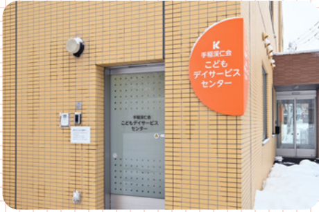
こどもデイサービスセンターの外観
